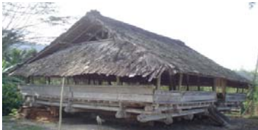
Pembangunan rumah adat
